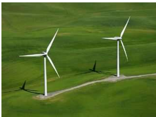
Obr. 4 Větrné elektrárny (Nalezno, 2018).
