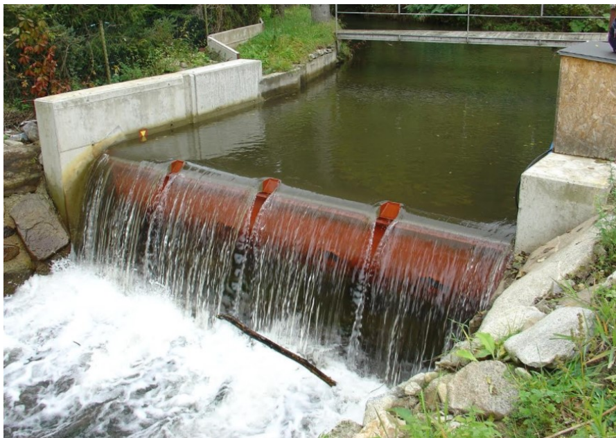
Obr. 2.9 – Jezová sklopná klapka
