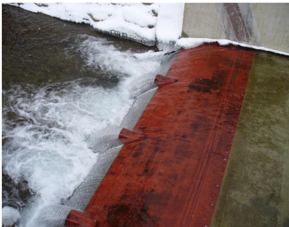
Obr. 2.10 – Sklopná jezová sklopná klapka
