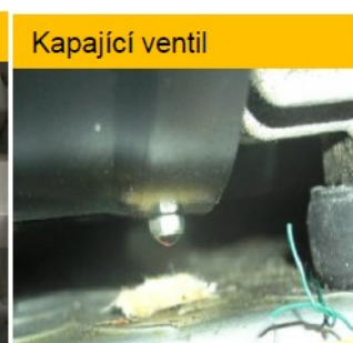
Obrázek 16 Kapající ventil
