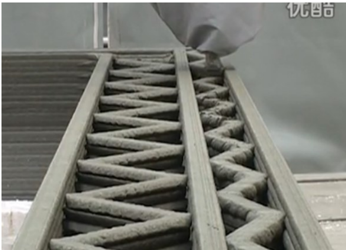
Obrázek 16: 3D tisk budovy (32)
