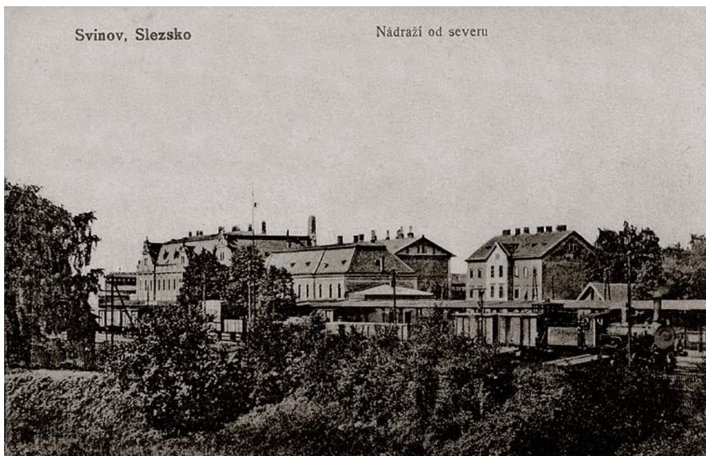
Obr. 3 Bývala budova riešeného územia z roku 1 920 [13]
