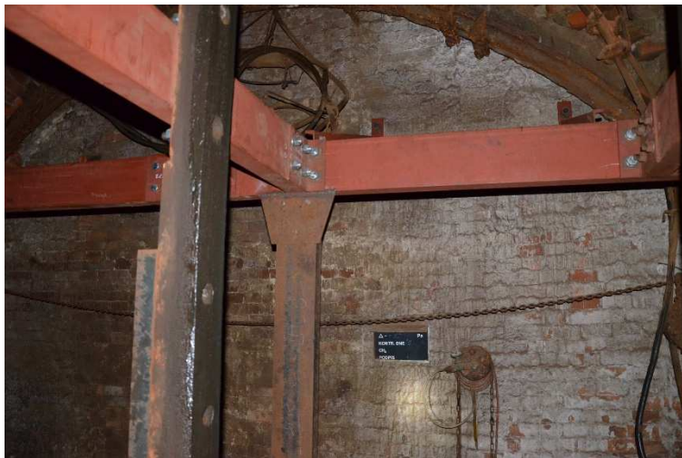
Obr. 4.13: Nová předezdávka.: 02029, průvodnicové tahy dopravní nádoby těžního zařízení v jámě Je-1 a detail ocelové obloukové výztuže. Foto autora
