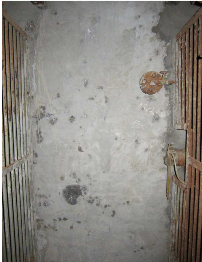
Obr. 4.14: Opravená UH č.: 04036 v jámě Je-1. [5]
