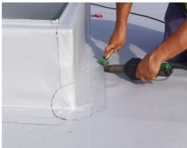
Obrázek 7: Napojení fólie na střešní výlez [31]
