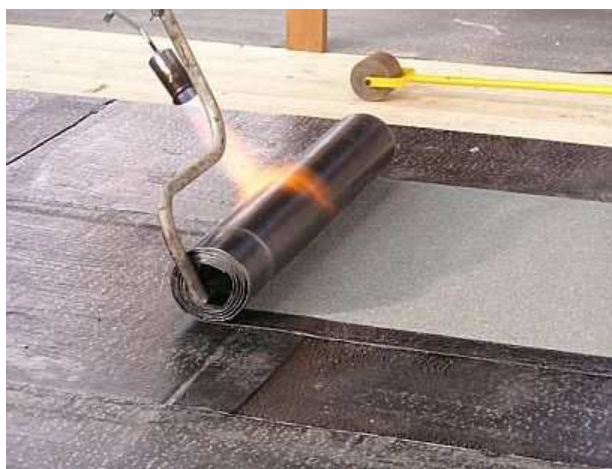
Obrázek 2: Natavení asfaltového pásu [26]
