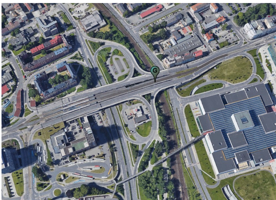
Obr. 26: Lokalizace objektu vůči železniční trati
