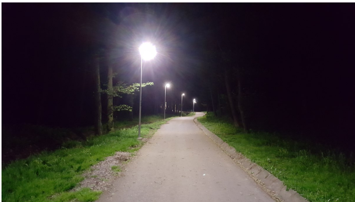
Obr. 16 Nasvětlení chodníkové trasy lesoparku v obci Orlová – LED svítidlem bez optiky
