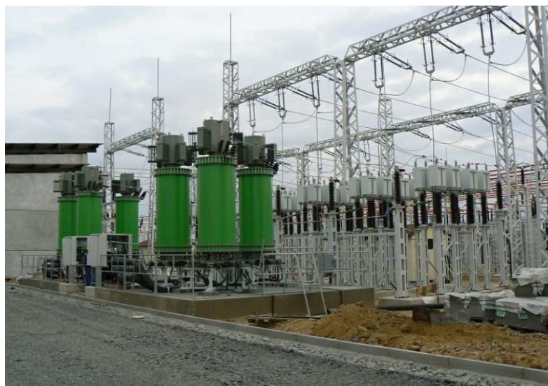
Obrázek 2. Vysílače HDO pro síť vn, 110 kV
