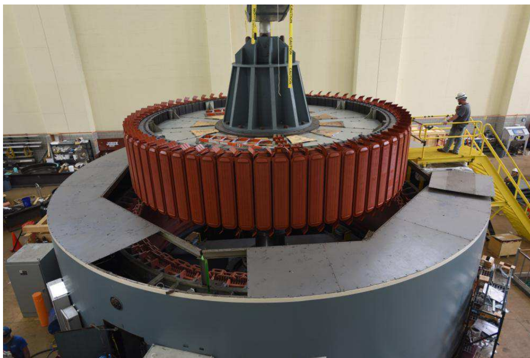
Obrázek 1.1: Rotor synchronního generátoru při vkládání do statoru.[11]
