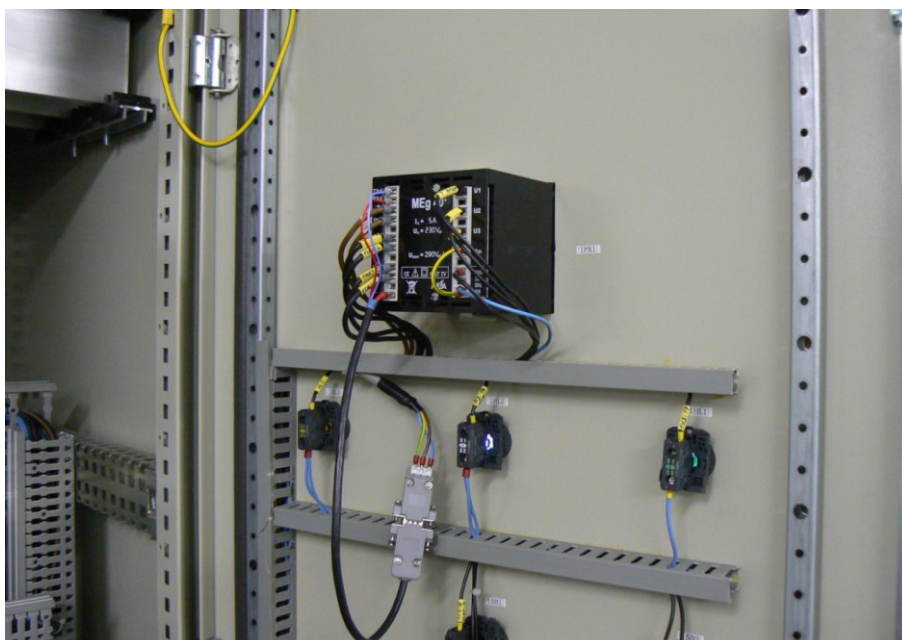
Obr. 4.13 Instalace MEg40+ v rozvaděči
