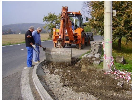
Obrázek 2.4 Výstavba chodníku, zdroj: TS a.s.
