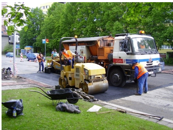
Obrázek 2.9 Opravy komunikací, zdroj: TS a.s.
