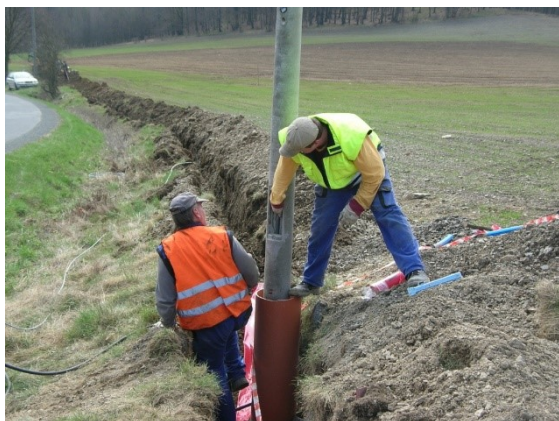
Obrázek 2.11 Výstavba osvětlení, zdroj: TS a.s.
