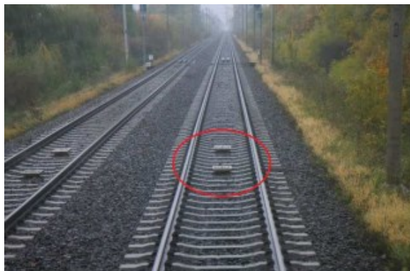
Obrázek 4.14: Eurobalizy umístěné v ose mezi kolejemi, převzato z [83].
