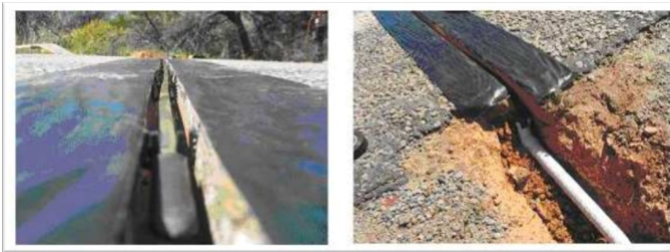
Obrázek 4.3: Princip implementace piezoelektrického senzoru v praxi, převzato z [31].
