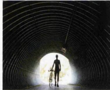
(d) Corrugated tunnel ( http://www.robgalbraith.com )
