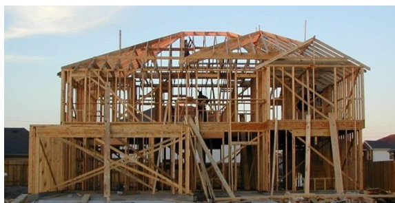
a. Estructura de vivienda. Balloon Frame.
