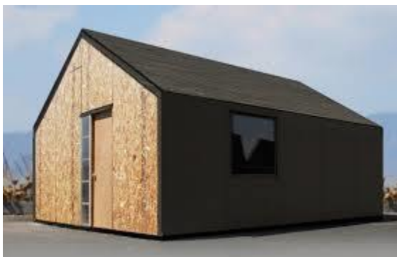
a. Imagen del prototipo construido.
