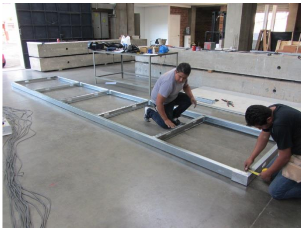
Figura 164. Construcción de la retícula de la estructura del techo.
