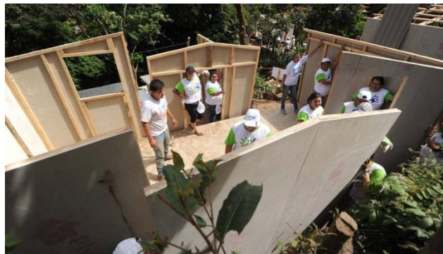
Figura 62. Construcción del modelo TECHO, Comunidad Zona Verde, Nuevo Cuscatlán, 2016. [71]
