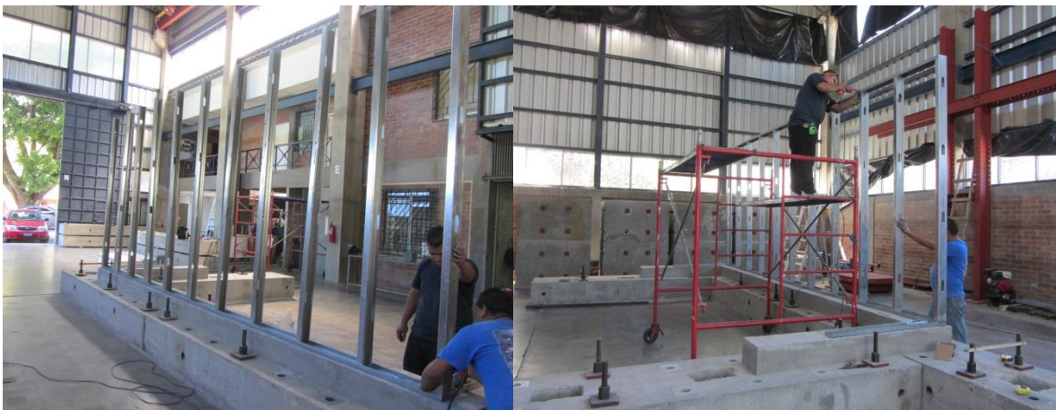
Figura 160. Colocación del perfil de anclaje superior de la Pared 1.
