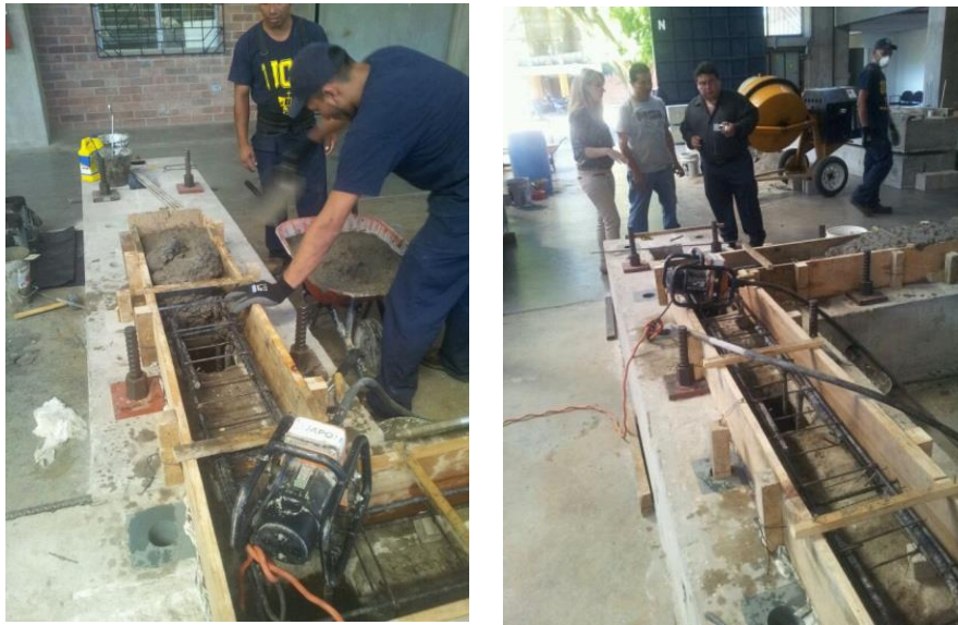
Figura 157. Proceso de colado de la Solera de Fundación.
