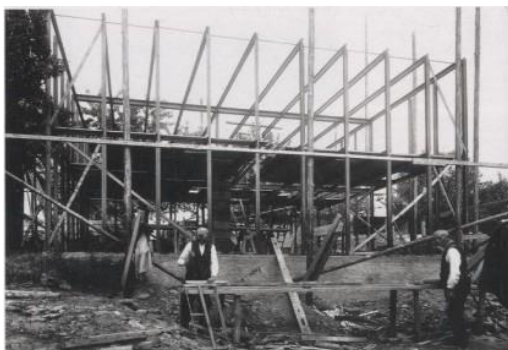
a. Construcción de la vivienda,
