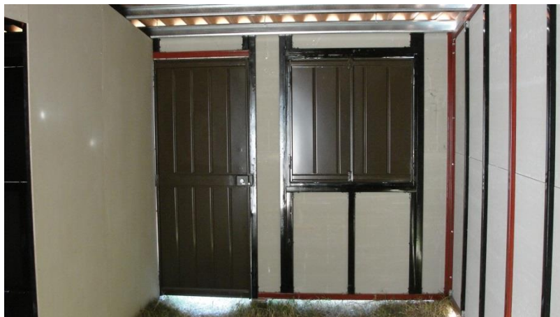
Figura 64. Detalle interior de vivienda tipología Plycem. [71]
