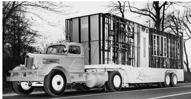
Figura 37. Transporte de los componentes de una Casa Lustron. [46]
