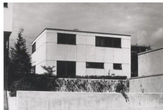
b. Prototipo construido de la vivienda.
