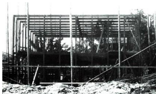
b. Construcción Prototipo de Casa nº 17.
