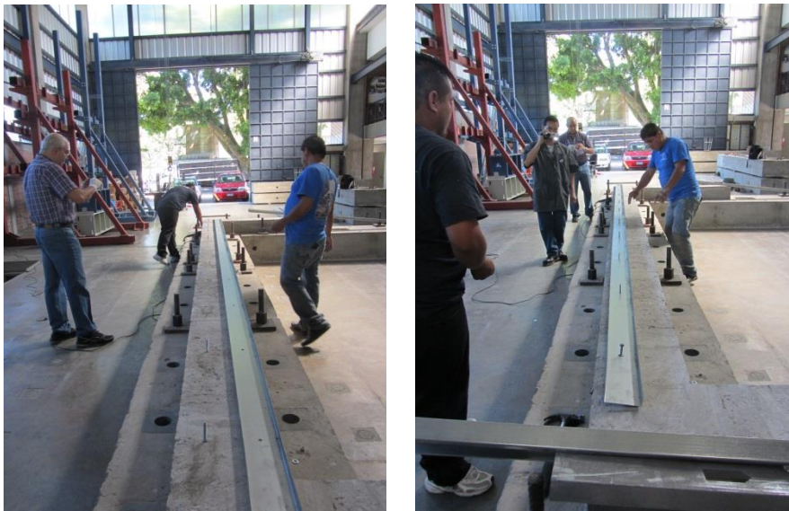
Figura 158. Colocación del Perfil de Anclaje de la Pared 1 sobre la Solera de Fundación.
