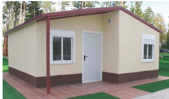
Figura 205. Vivienda social de 45 m2 con sistema SPFA.
