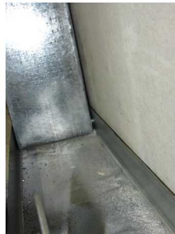
Figura 179. Separación lámina-perfil.
