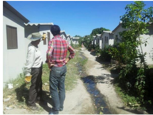
b. Colonia de viviendas tipo PLYCEM.
