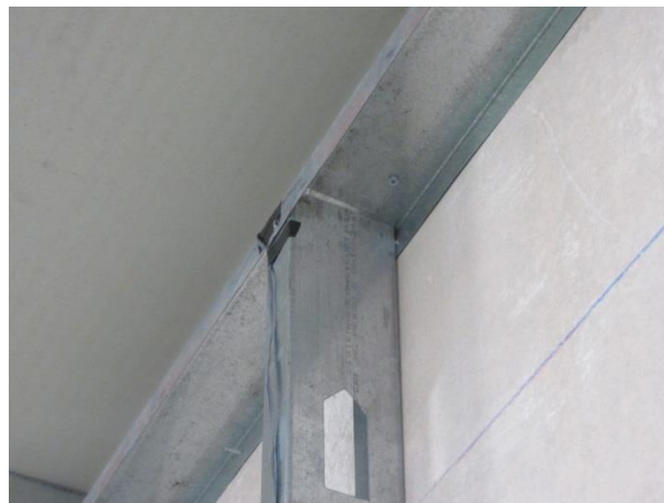
Figura 180. Torsión perfil de anclaje PA.
