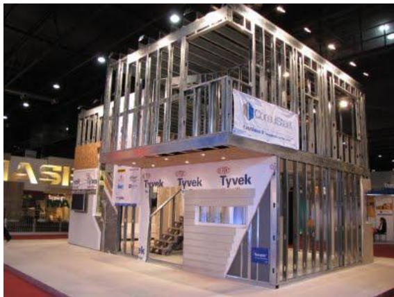
Figura 20. Exposición de prototipo de vivienda con sistema Steel Framing. [49]
