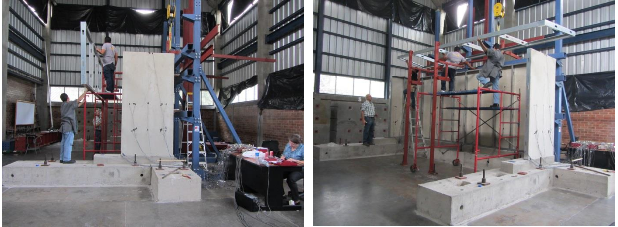
Figura 165. Colocación de la retícula de la estructura del techo.
