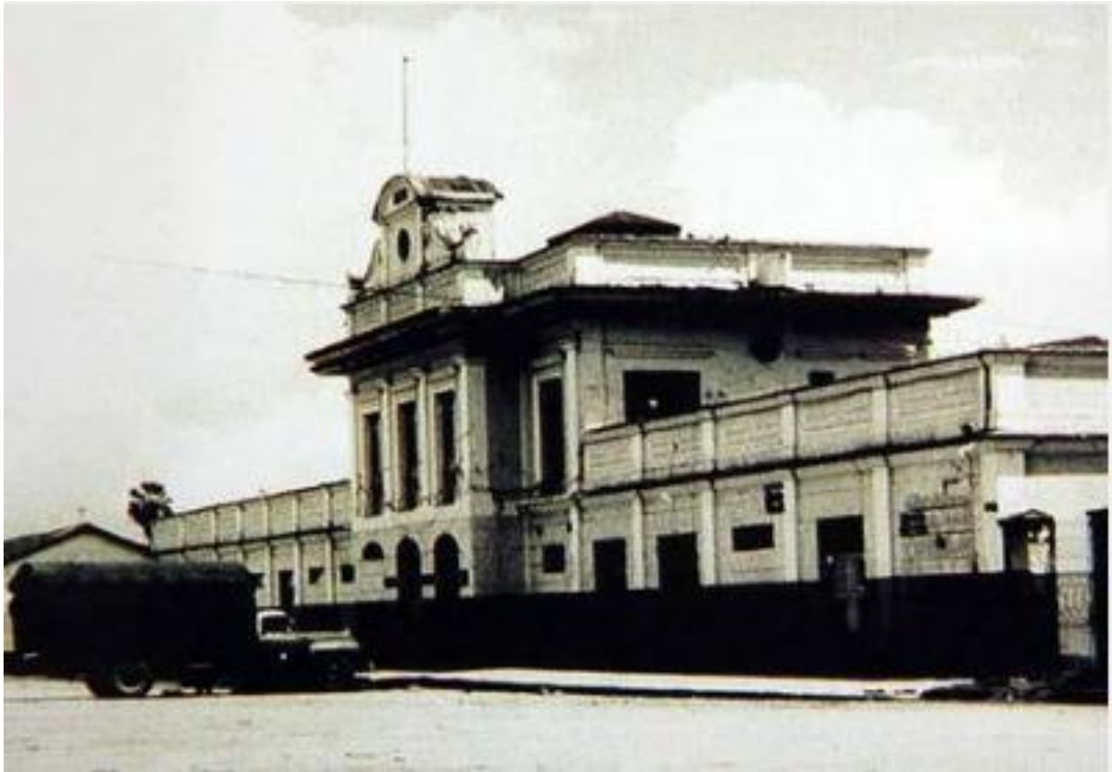
Figura 9. Estación del Ferrocarril.
