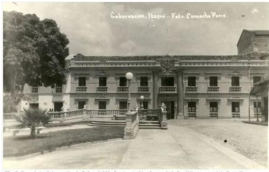
Figura 5. Edificio de la gobernacion del tolima 1920.
