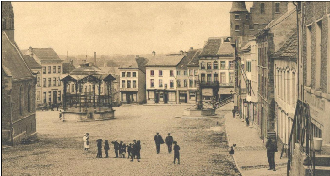
Figuur 18. Detail uit een postkaart van de “Paardenmarkt”, gezien vanuit de Vesten. De panden van de S.M. De Verbroedering liggen in de rechter huizenrij, tussen de kasseiwegjes die het voetpad onderbreken en naar de steegjes lopen die links en rechts de percelen omsluiten
