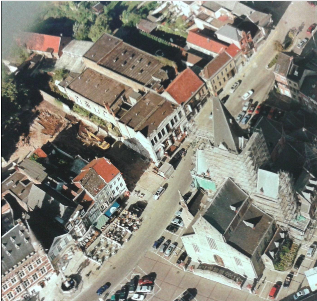
Figuur 28. Deze luchtfoto van de Markt in Geraardsbergen van op 15 augustus 2000 toont het Volkshuis (Markt 15) en het aanpalende pand (Markt 17) met hun achterliggende bouwsels, naast het gesloopte perceel Markt 13 (voormalig KBC-kantoor) waar graafwerken aan de gang zijn. Bron: DE RO & SURDIACOURT, Het Schoonste Spektakel , p. 204
