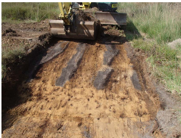
Figuur 12: Aanleg sleuf 1 met de eenmalig verploegde Podzol bodem.
