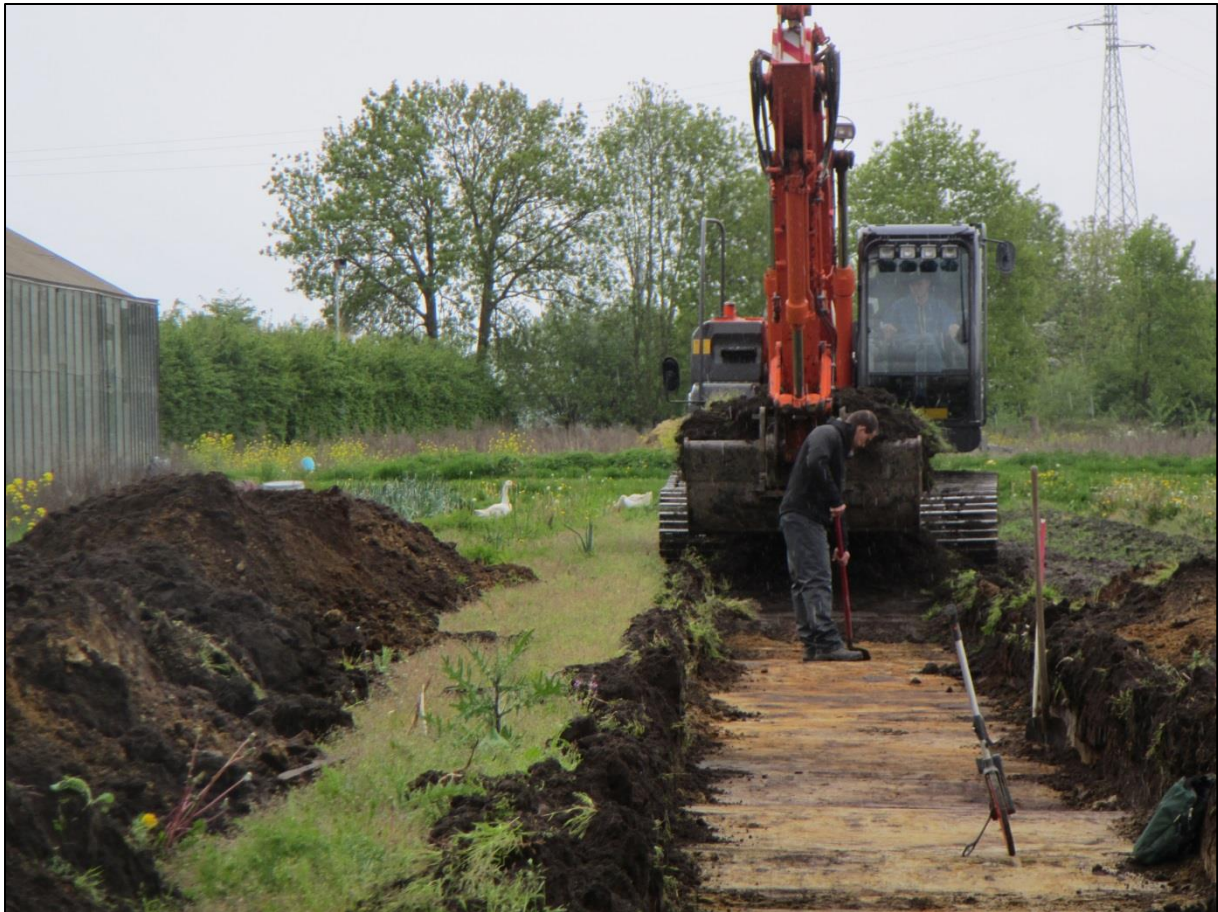
Fig.10, 11 en 12 : sfeerbeelden aanleggen van sleuven
