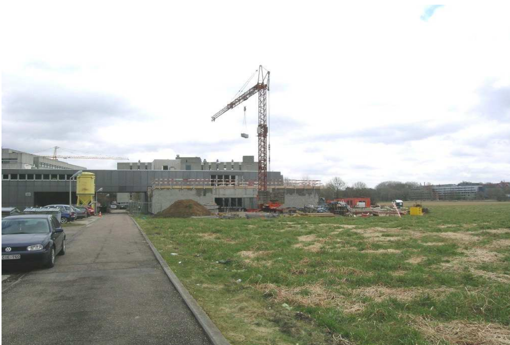
Fig. 3: Het terrein voor de aanvang van de fieldschool . De bouwwerf is de uitbreiding van het bestaande gebouw Kapeldreef 62 te Heverlee, waar in 2011 en 2012 de sleuven voor de fieldschool werden aangelegd. Ook zichtbaar is de weg langs waar de nieuwe sleuven zullen worden getrokken op het terrein dat rechts op de foto zichtbaar is.
