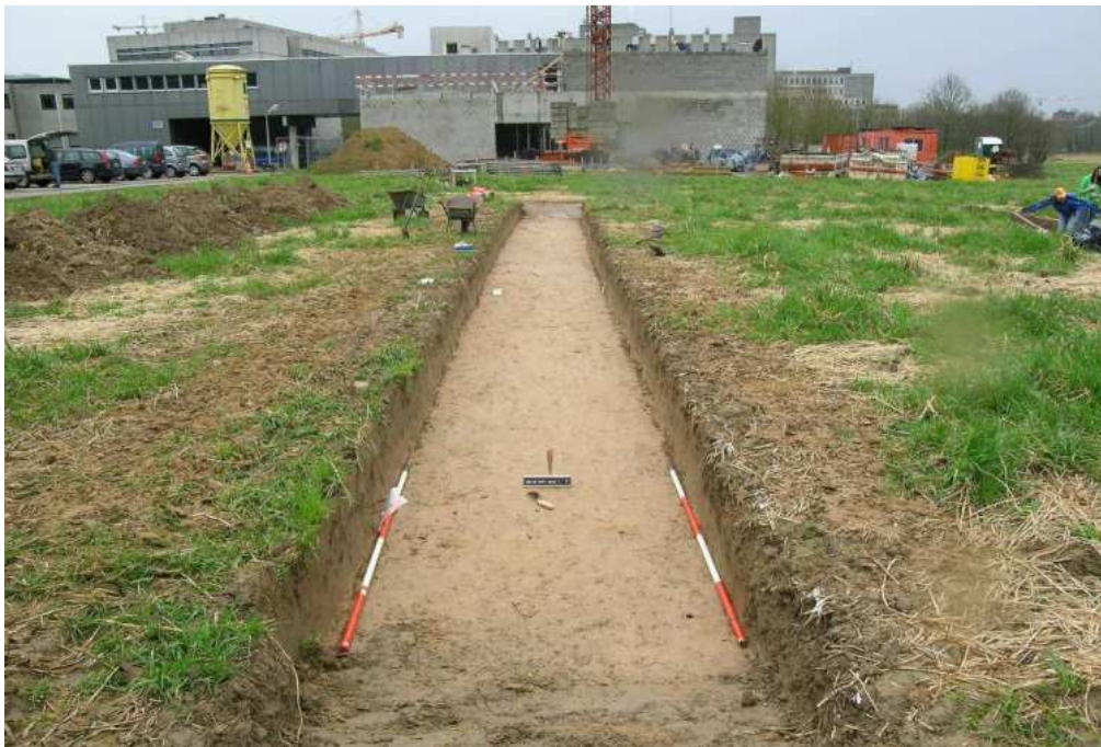
Fig. 10: De tweede sleuf nadat ze een eerste keer werd opgeschaafd. Op de achtergrond is de bouwwerf van de nieuwbouw zichtbaar.
