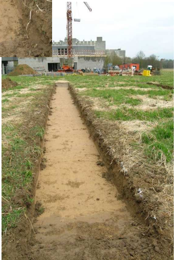
Fig. 7: De tweede noordelijke sleuf na het openleggen.
