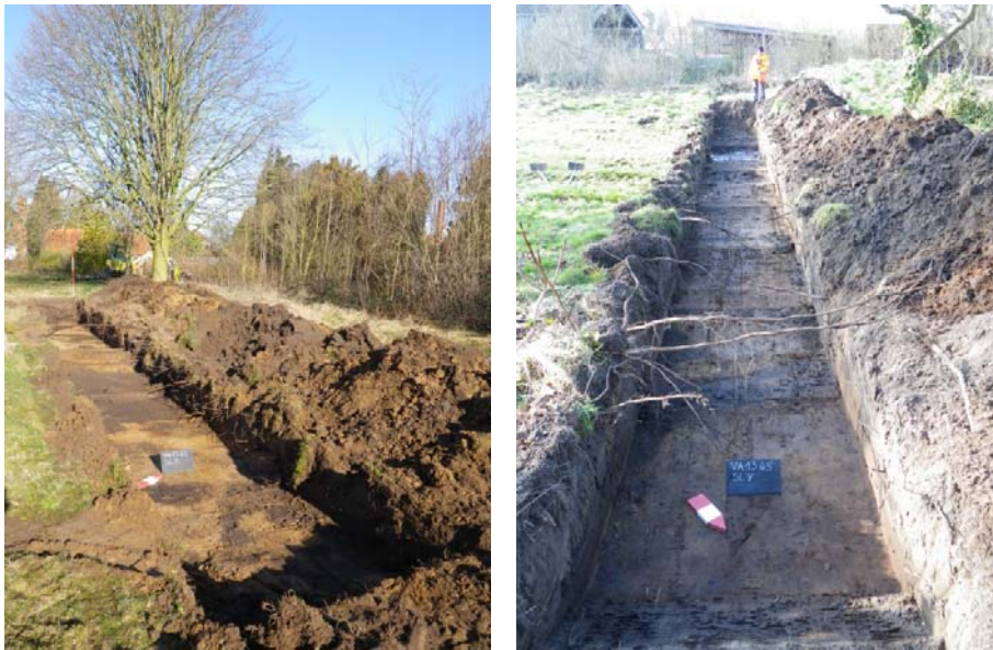
Figuur 11 & 12 : Zicht op sleuf 3 & 4.
