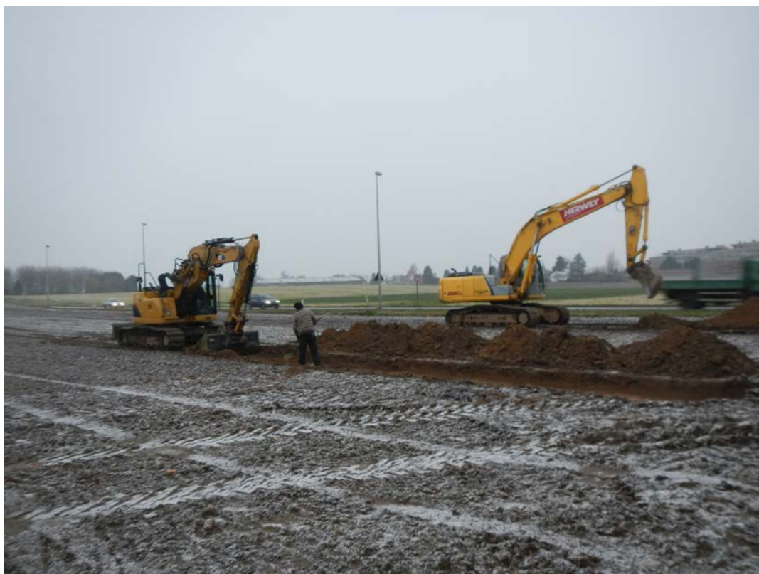
Afbeelding 13: Sfeerfoto tijdens de aanleg van de werkputten 1 en 2 in het uiterste noordwesten van het plangebied. De werkputten werden aangelegd door middel van twee hydraulische rupskranen met een gewicht van respectievelijk 18 (links) en 22 ton (rechts).
