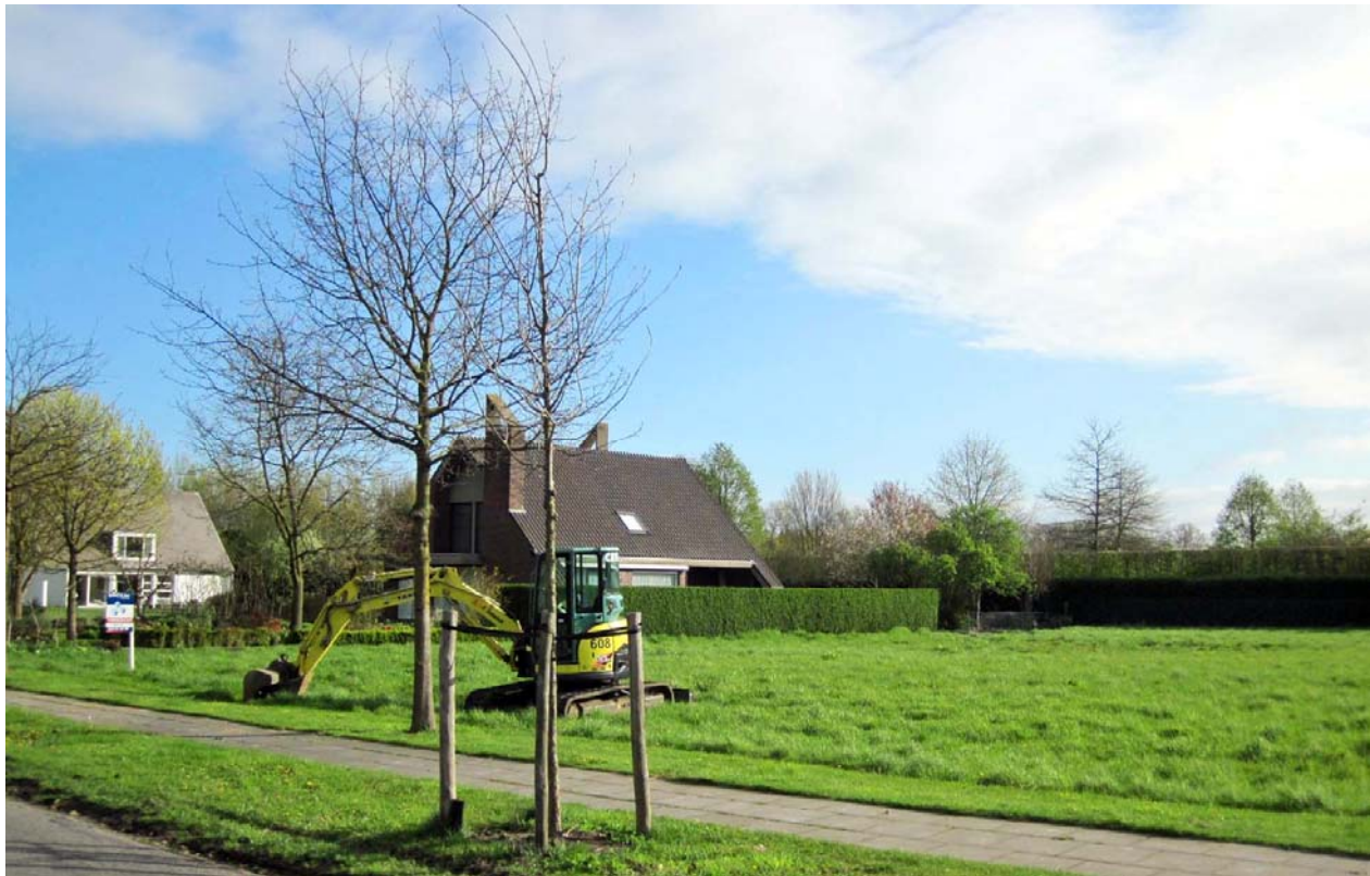
Fig. 2: Terreinopname van het projectgebied
