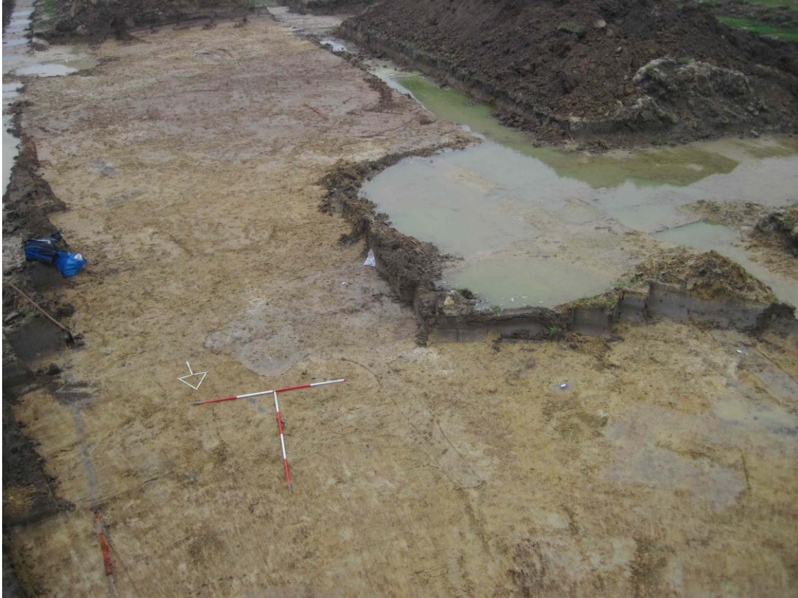
Fig.21: KV9 tussen SL40-41.
