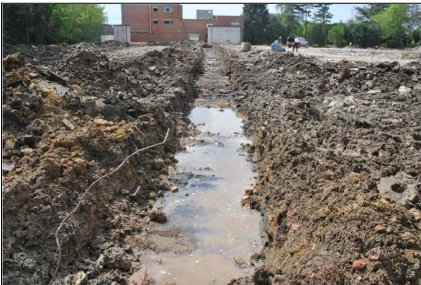
Afb. 12: Zicht op Proefsleuf 2.
