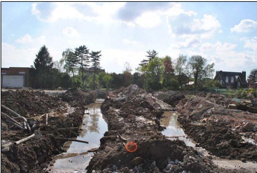
Afb. 11: Proefsleuven 4 en 5 na het couperen van de beek.
