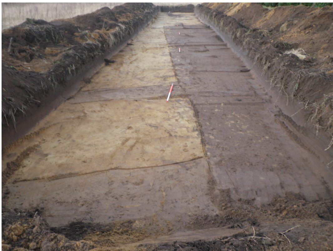
Afbeelding 10: Grootschalige zandontginning in werkput 11.
