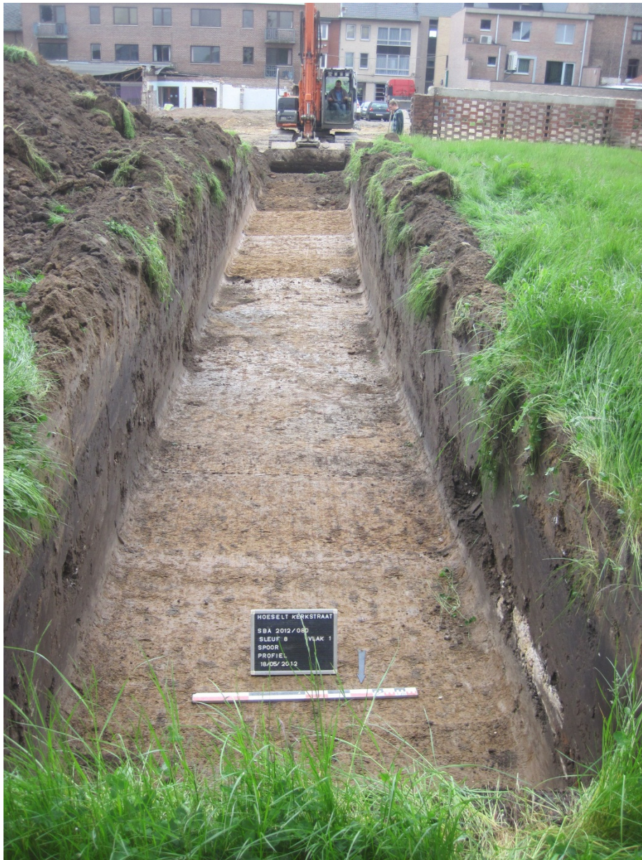
Fig. 15: Aanleg van de sleuven.
