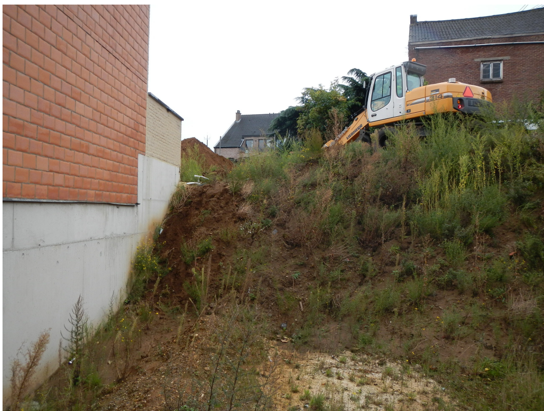
Afbeelding 9: Foto genomen vanuit de afgraving met, ter hoogte van het oorspronkelijke maaiveldniveau de graafmachine tijdens het ontgraven van de werkput.
