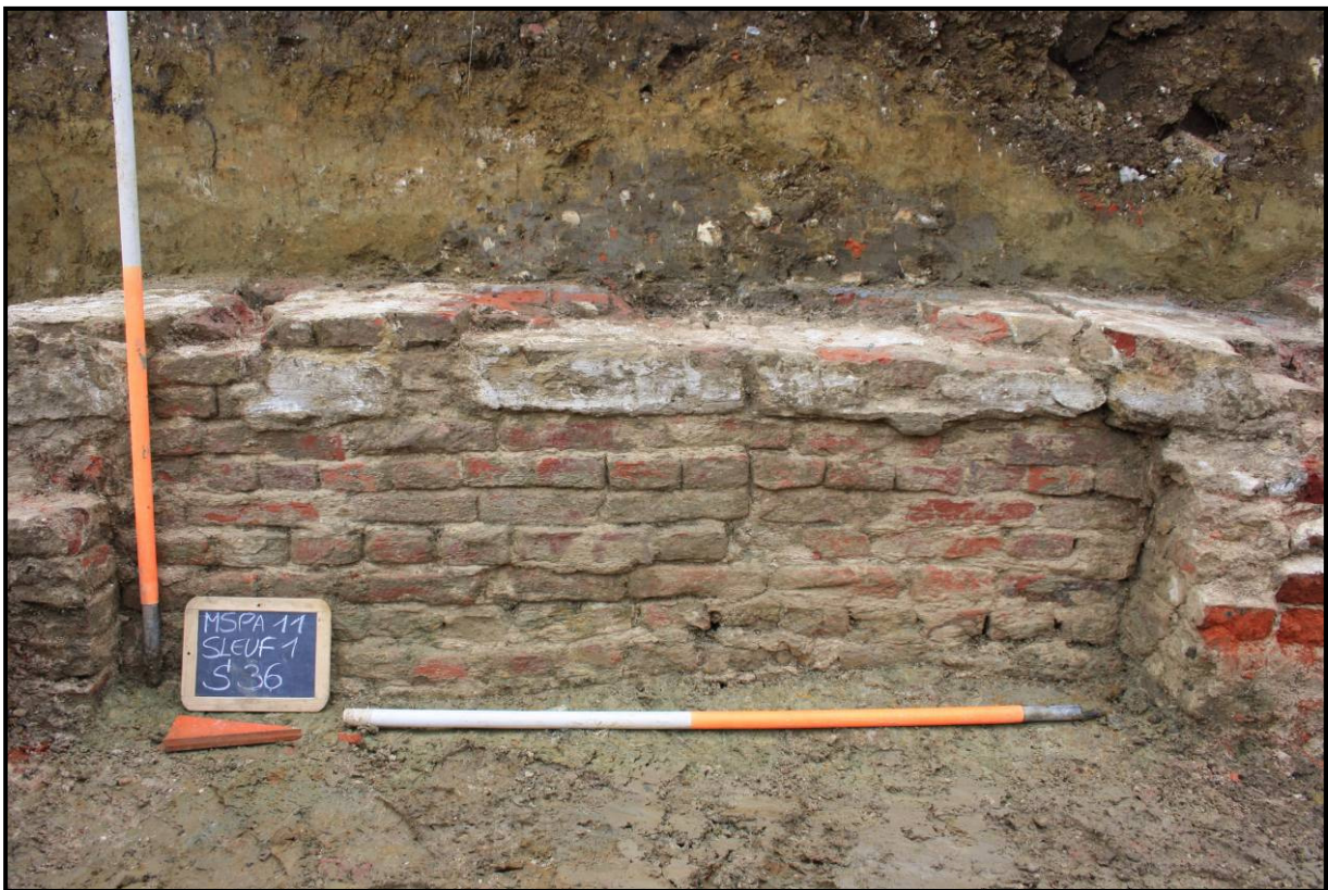
Figuur 25: Resten van pleisterwerk op de westelijke buitenmuur van de pastorie.
