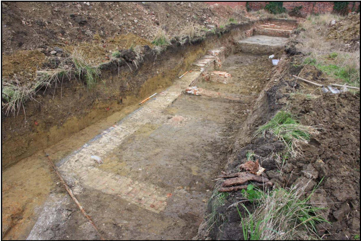
Figuur 24: Zicht op de funderingen van de westelijke buitenmuur van de pastorie met steunberen langs de binnenkant. Het noorden bevindt zich bovenaan de foto.
