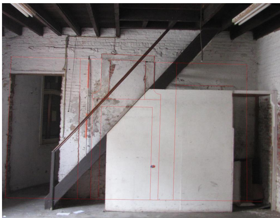
Fig. 9 met aanduiding van de dichtgemetselde en voor een groot deel achter een trap verborgen deuropening met omlijsting in natuursteen en bovenlicht
