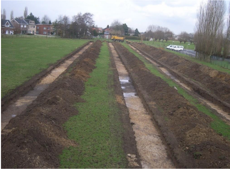
Fig 21: Overzicht sleuf 15, 16 en 17
