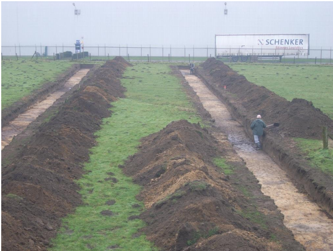
Fig 7 : Overzicht sleuf 1 en 2
