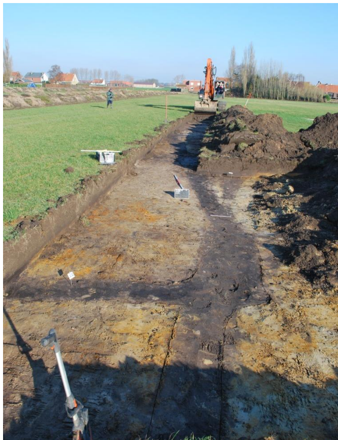
greppelfragmenten in sleuf 16
