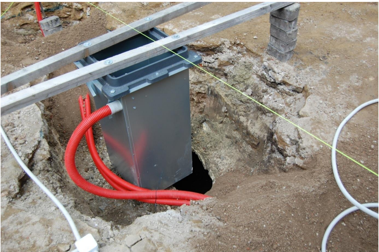
De doorbreking in het gewelf, zichtbaar onder de basis voor de bewakingscamera
