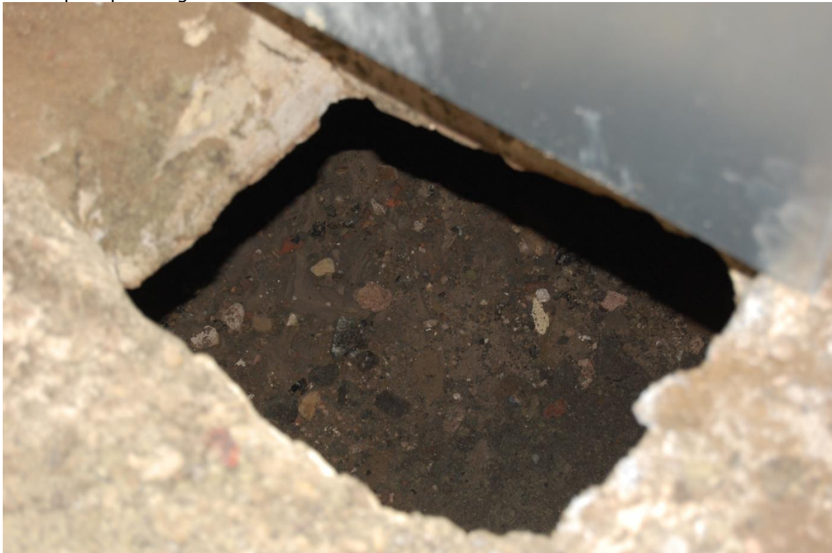
Zicht op de puinlaag in de kelder
