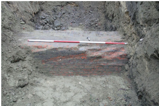
Fig. 9. De fundering van de laat-18 de -eeuwse kaaimuur
