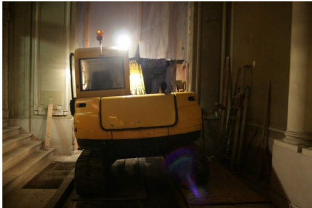
Fig. 7. De grootte van de kraan was sterk afhankelijk van de beperkte breedte van de poortdoorgang
