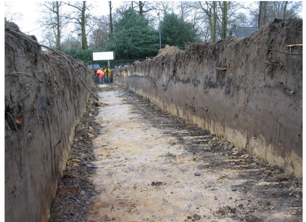
Figuur 7: wandprofiel sleuf 1
