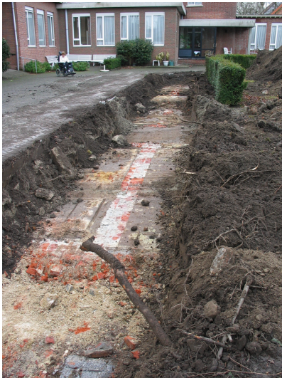
Figuur 4. recente kelderfundering sleuf 8
