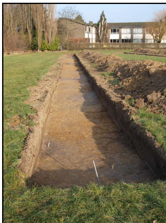
Figuur 5: Zicht op sleuf 3.
