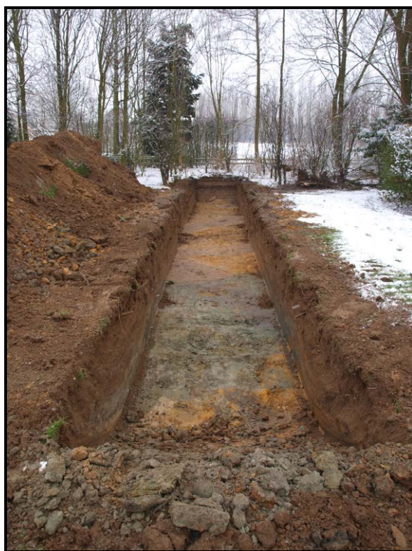
Figuur 58: Zicht op sleuf 5.
