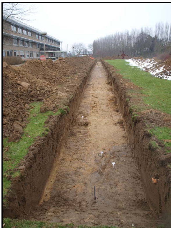
Figuur 32: Zicht op sleuf 16.
