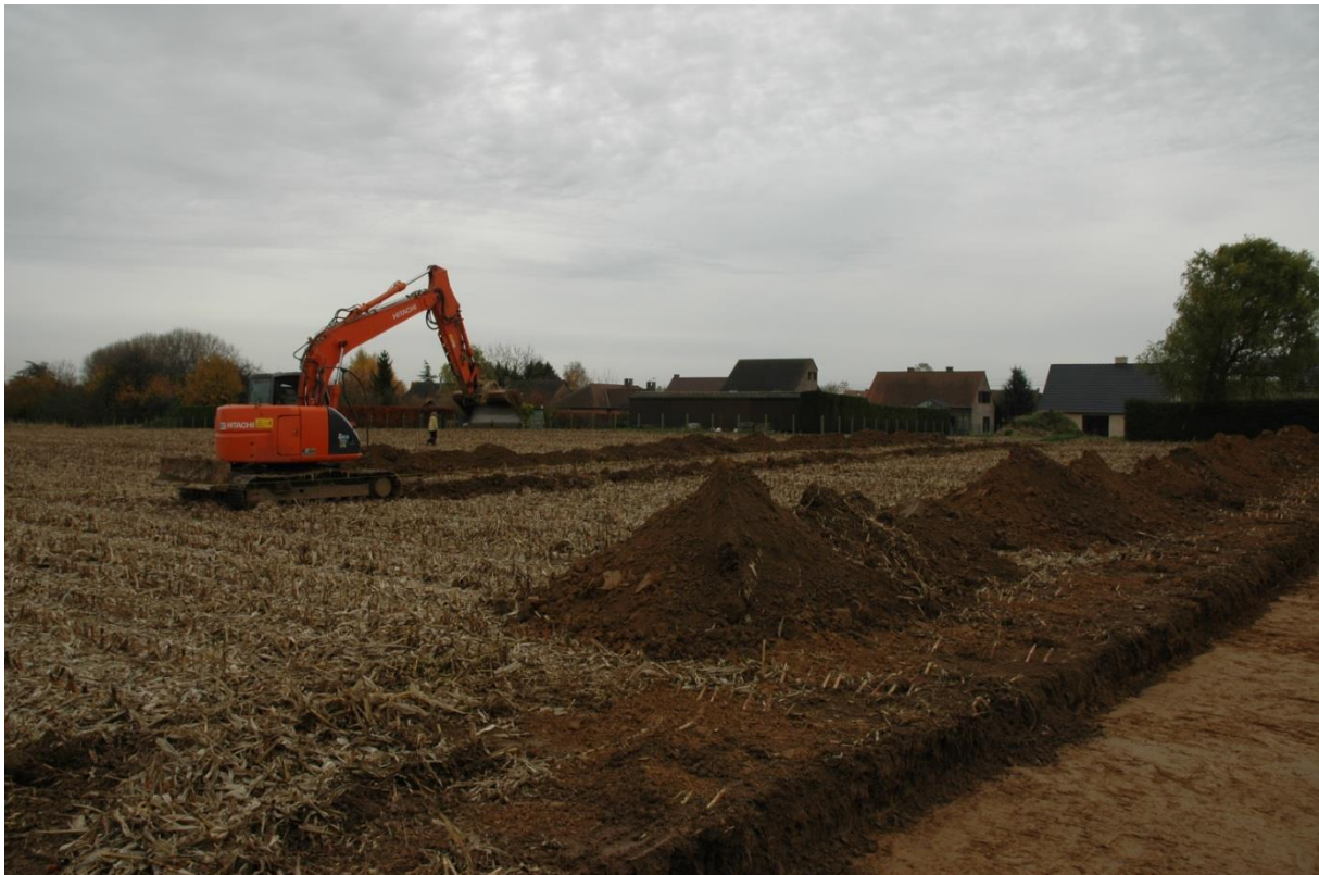
Fig. 5: Machinaal aanleggen van de sleuven.
