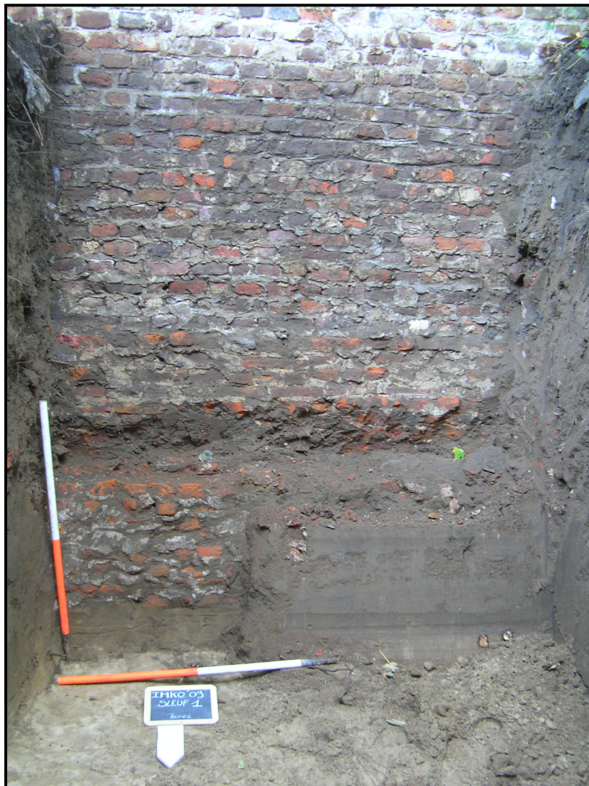
Figuur 6: Zicht op de kasteelmuur en fundering in sleuf 1.
