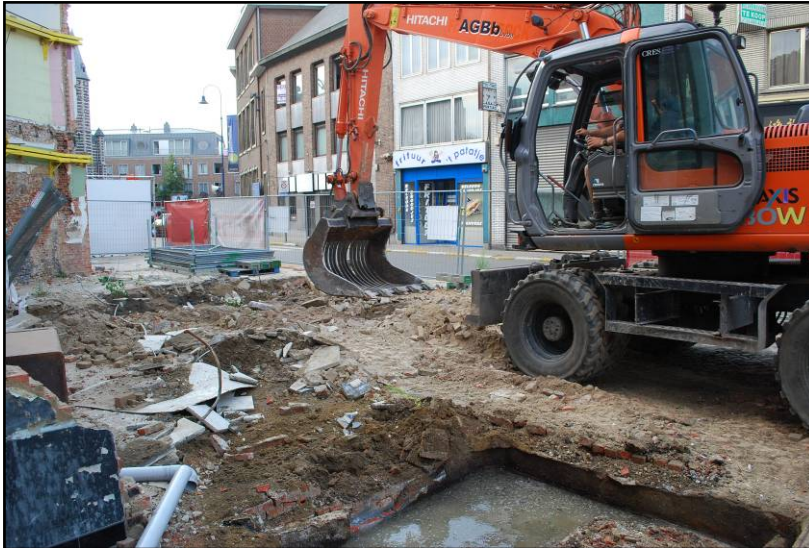
Fig. 7: Aan de zijde van het Gemeenteplein bevinden zich de resten van kelders hoerend bij de recent gesloopte gebouwen. Er werden enkele buizen, een cisterne en een waterput aangesneden in deze zone. Allen waren nog watervoerend. (Foto: ARON bvba)
