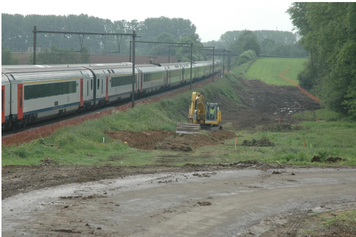
Fig. 7: Uitgraven van de proefsleuf langsheen de bestaande spoorlijn.
