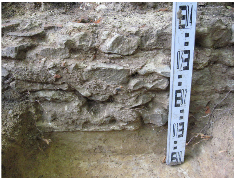
Afb. 30. Fundering binnenmuur put 16.
