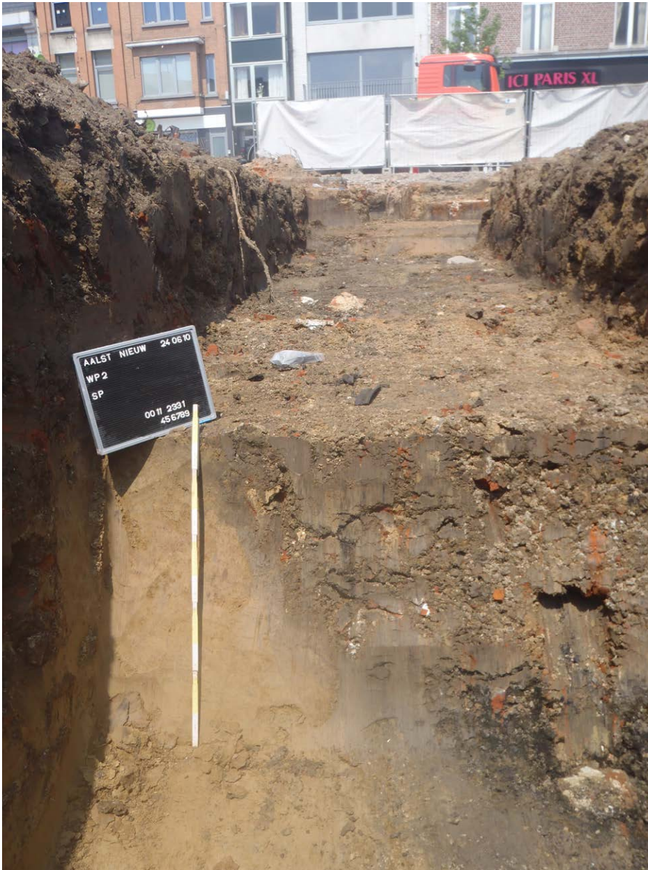
7. Verdiepte zone centraal in werkput 2
