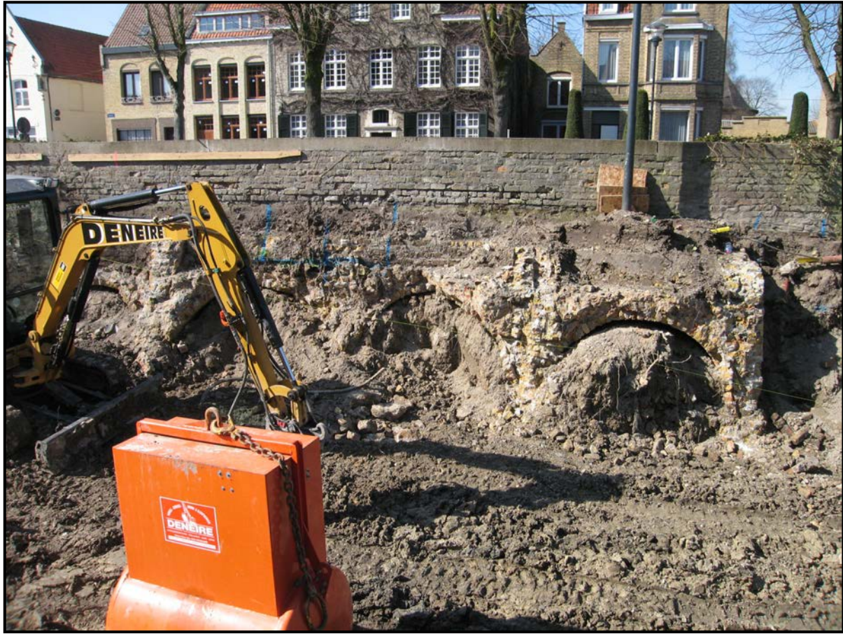
Figuur 34: Boogvormige kelderstructuren, aangetroffen bij de werfbegeleiding (© Sam De Decker).
