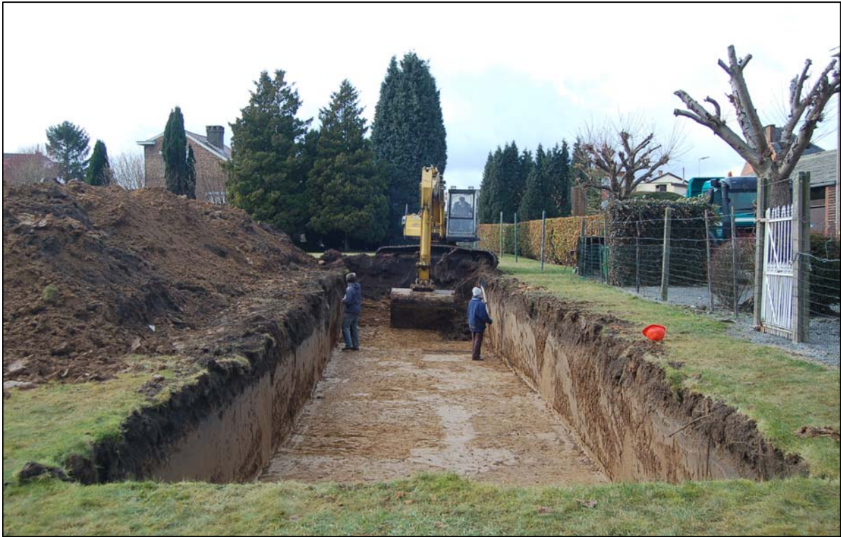
Fig. 7. Aanleg van werkput 1.
