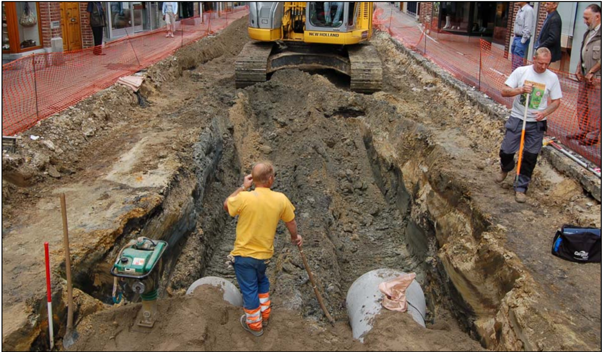
Fig 11. Zicht op de rioleringswerken in de Onze-Lieve-Vrouwstraat.
