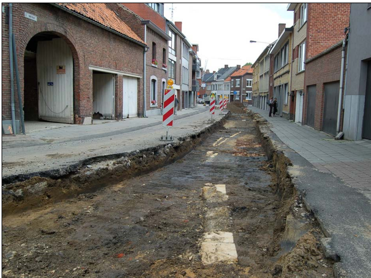
Fig. 13. Zicht op het vlak onder de westelijke zijde van de Omstraat, met op de voorgrond muur S 11.
