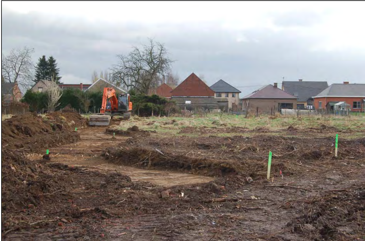
Afb. 7: aanleg van de sleuven, secties 1 tot en met 4. (Foto: ARON bvba)
