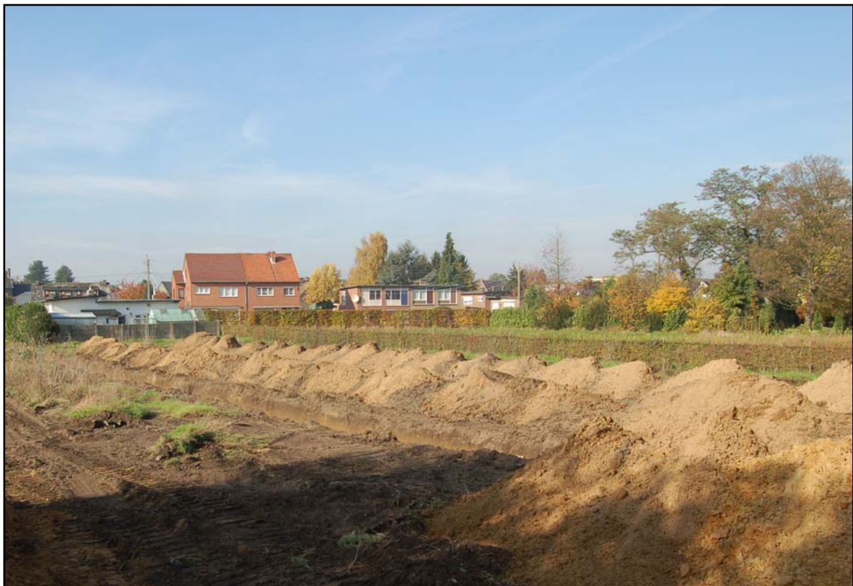
Afb.7: Zicht op sleuven 1 en 2 bij de aanleg (foto ARON bvba).
