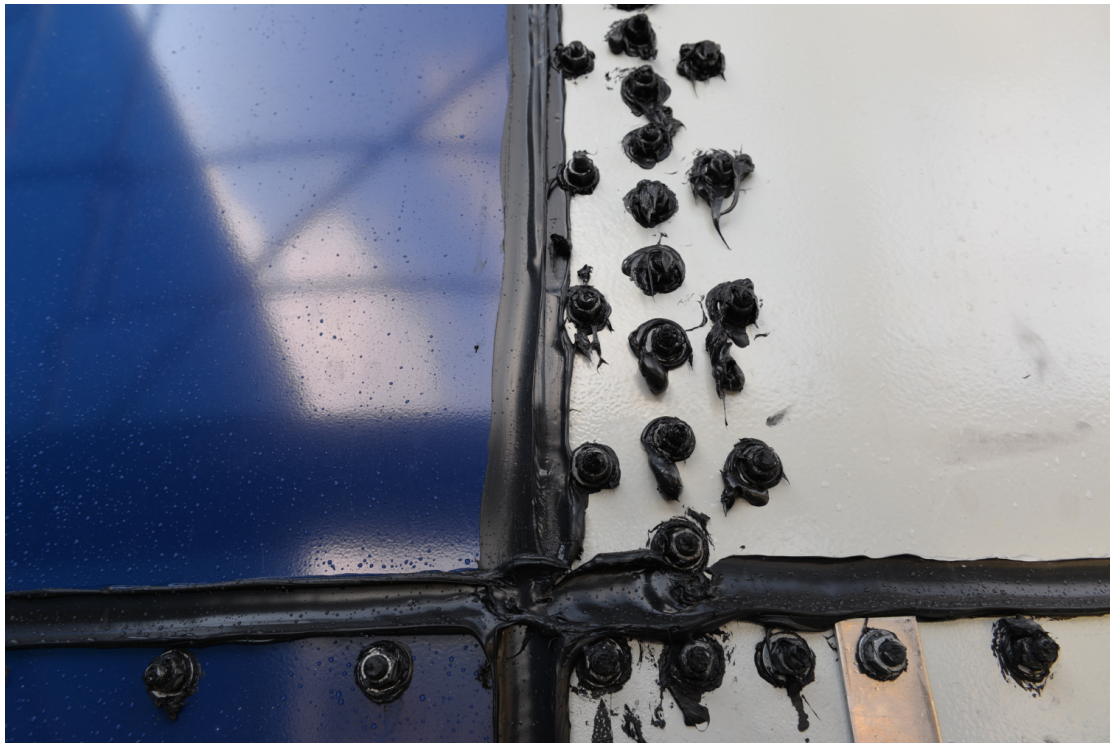
Abbildung 128: Demonstrator, Verwendung von Wandsegmenten mit verschiedenen Beschichtungswerkstoffen und des identifizierten Dichtstoffes, 28.04.2016
