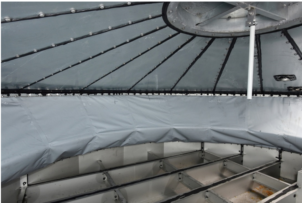
Abbildung 132: Demonstrator, Dachraum, flexible Abdichtung der Schwimmdecke, vor der Befüllung mit Rathipur (Wärmedämmstoff), 09.02.2017
