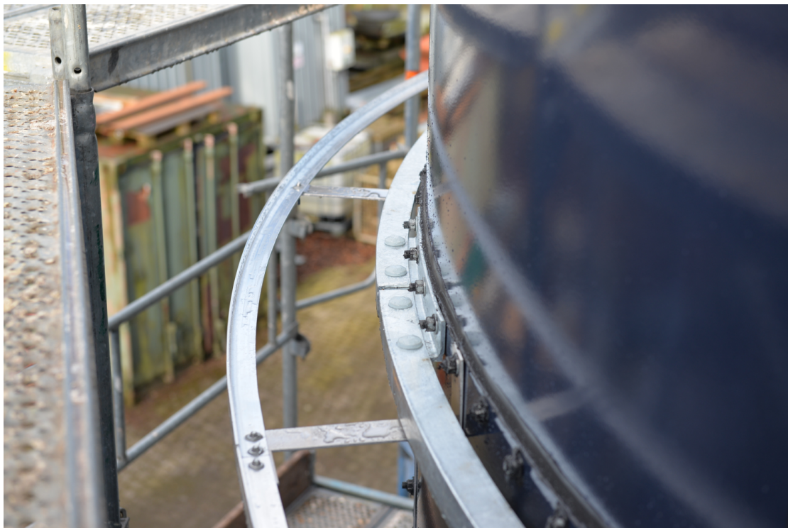
Abbildung 129: Demonstrator, Speicherwand mit Abstandshaltern, 28.04.2016
