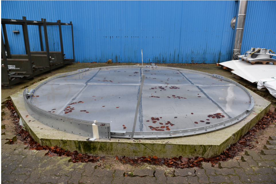
Abbildung 126: Demonstrator, Bodenplatte mit Bodenblech und Teile des Starterrings, 27.01.16
