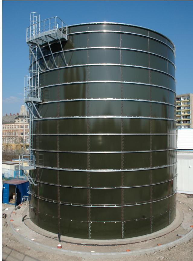
Abbildung 4: Kaltwasserspeicher in Chemnitz, 3500 m 3 , Bauphase der Wand 2007 [11]
