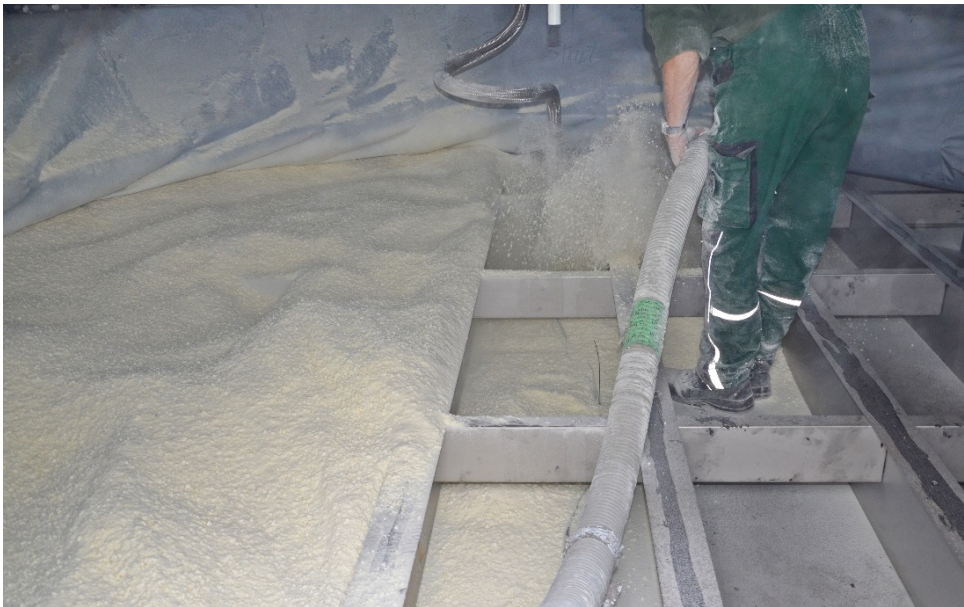
Abbildung 134: Demonstrator, Dachraum, Befüllung der Schwimmdecke mit Rathipur (Partikel aus recyceltem Polyurethan-Hartschaum), 13.06.2017
