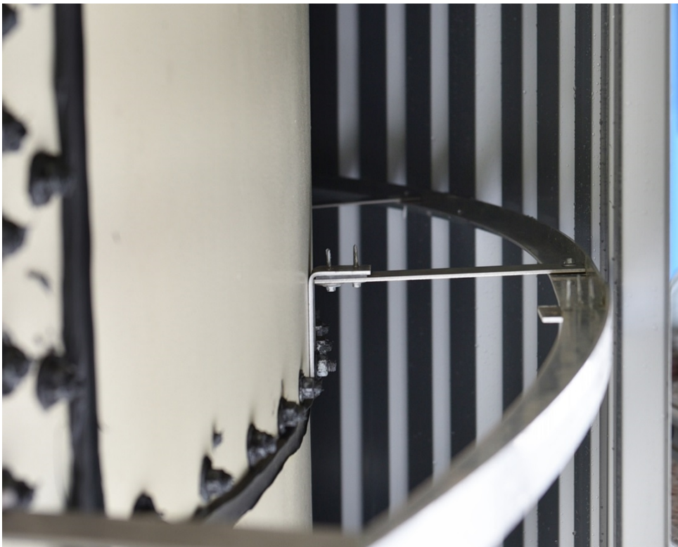
Abbildung 136: Wandaufbau, modifizierte Verkleidungsblechhalter und teilweise montiertes Verkleidungsblech, 16.05.2017
