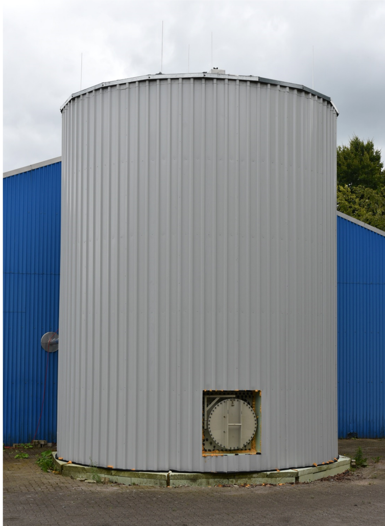
Abbildung 137: Demonstrator, Gesamtansicht nach Abschluss der Installation des Verkleidungsblechs und der Befüllung mit Rathipur, temporär nicht gedämmtes Mannloch, 13.07.2017
