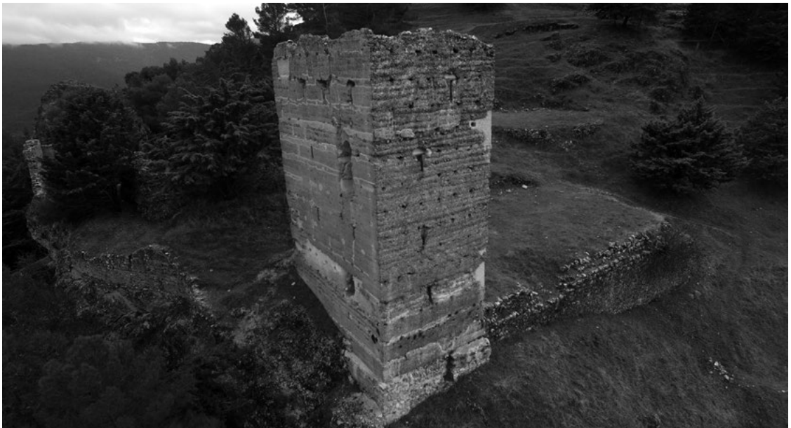
Vista de la torre y recinto de Góntar desde el Noreste, ocho años tras la consolidación llevada a cabo en 2009 (Fuente: los autores, 2017)
