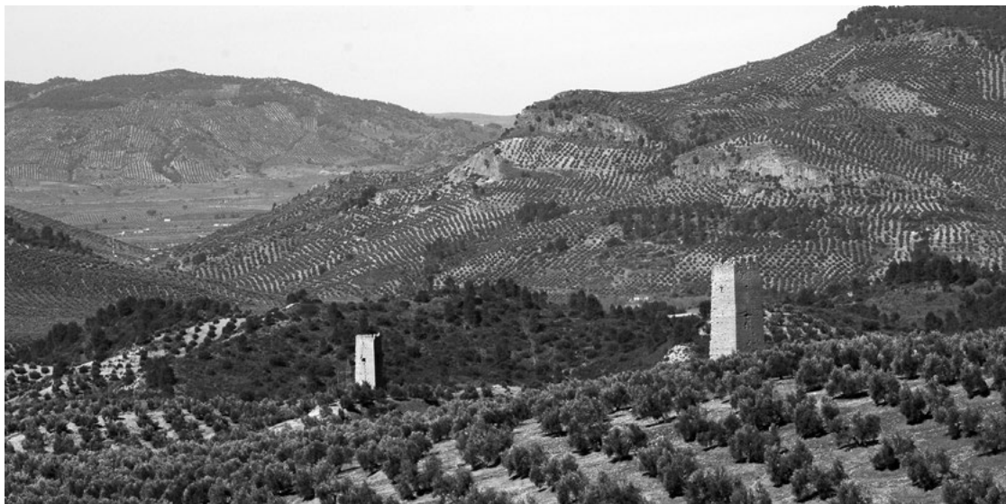
Atalayas de Santa Catalina en Orcera (Jaén), en primer término la torre Sur, al fondo la torre Norte. (Fuente: Santiago Quesada-García, 2003)
